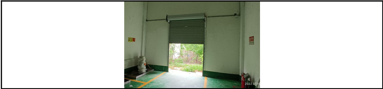
图8 项目危险废物暂存区
